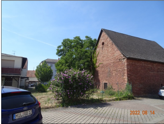
Scheune Klingenberger Straße 1
