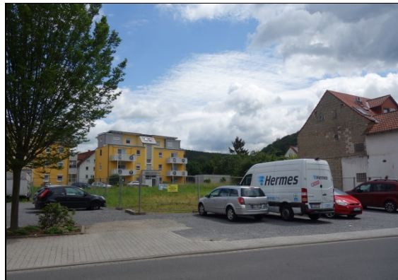
Blick von der Klingenberger Straße auf das Plangebiet
